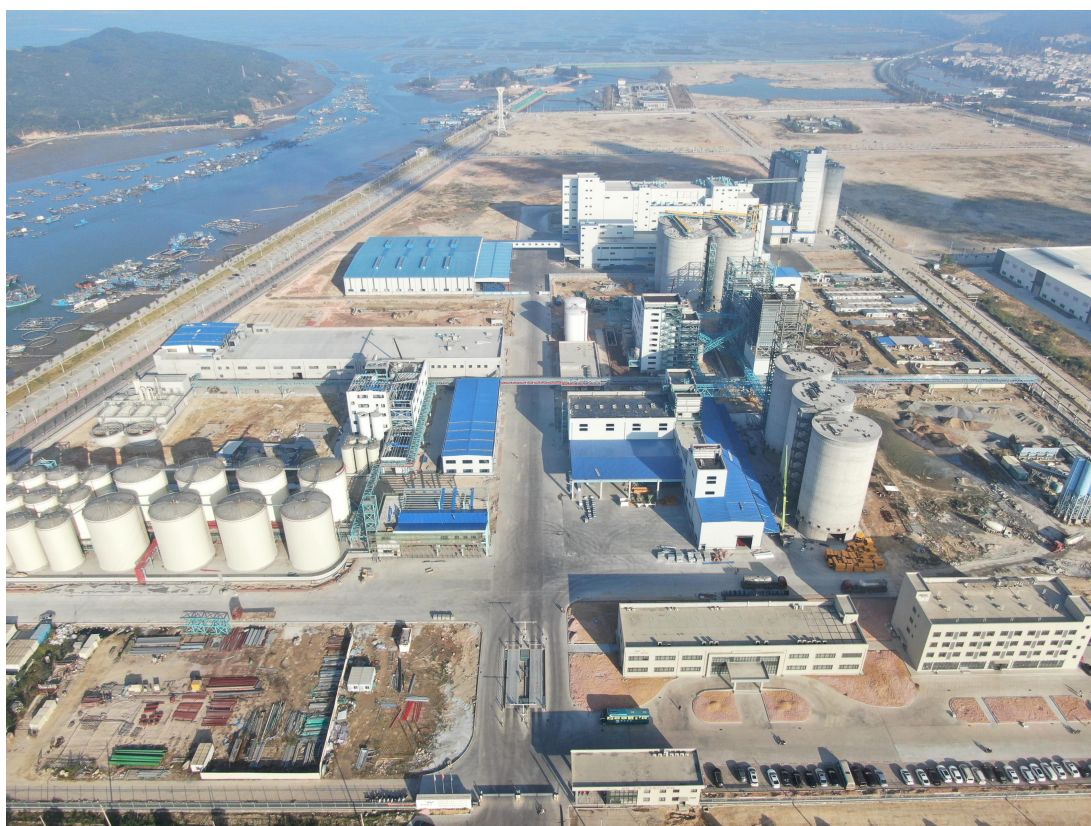
图 3-10 潮州益海嘉里粮油加工基地 (潮州港经济开发区管委会供图)
