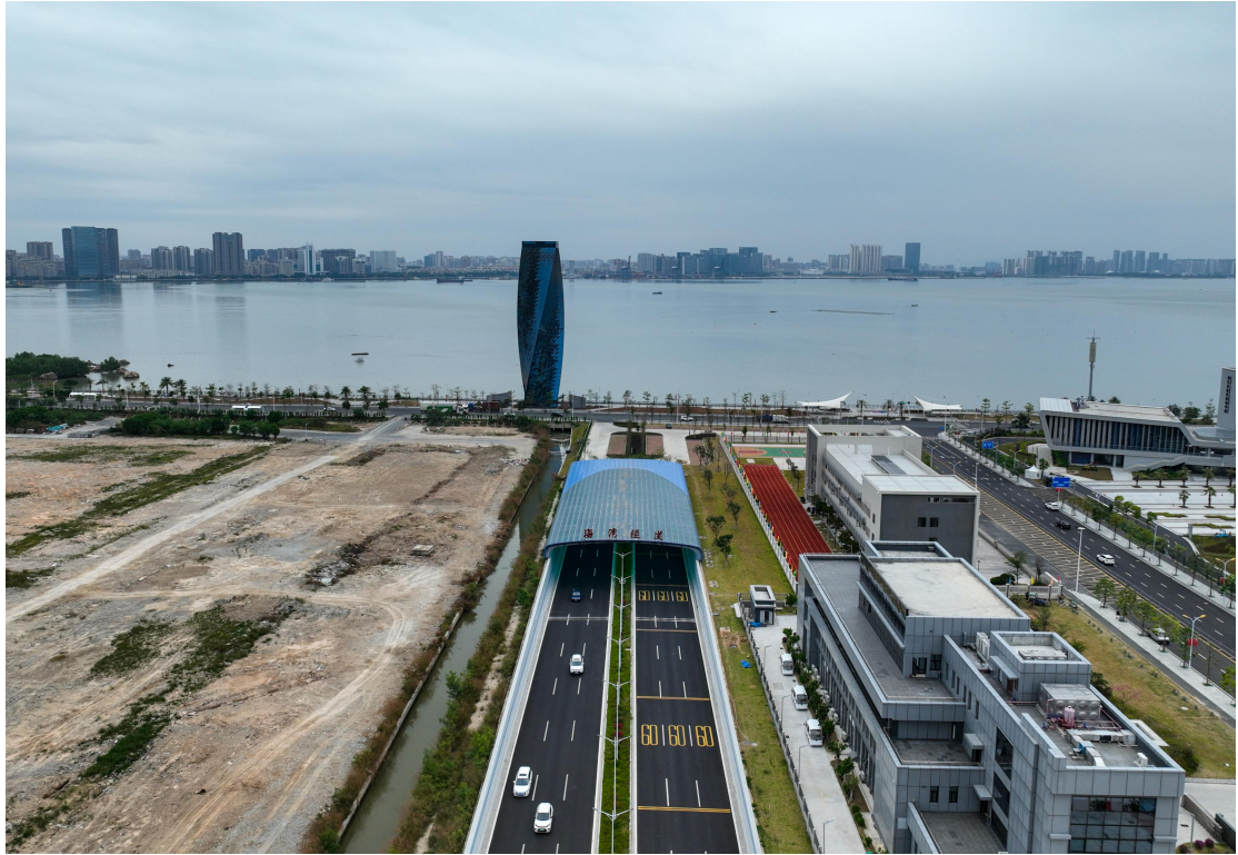
图 1-18 汕头市海湾隧道建成通车 (柯良斌供图)
