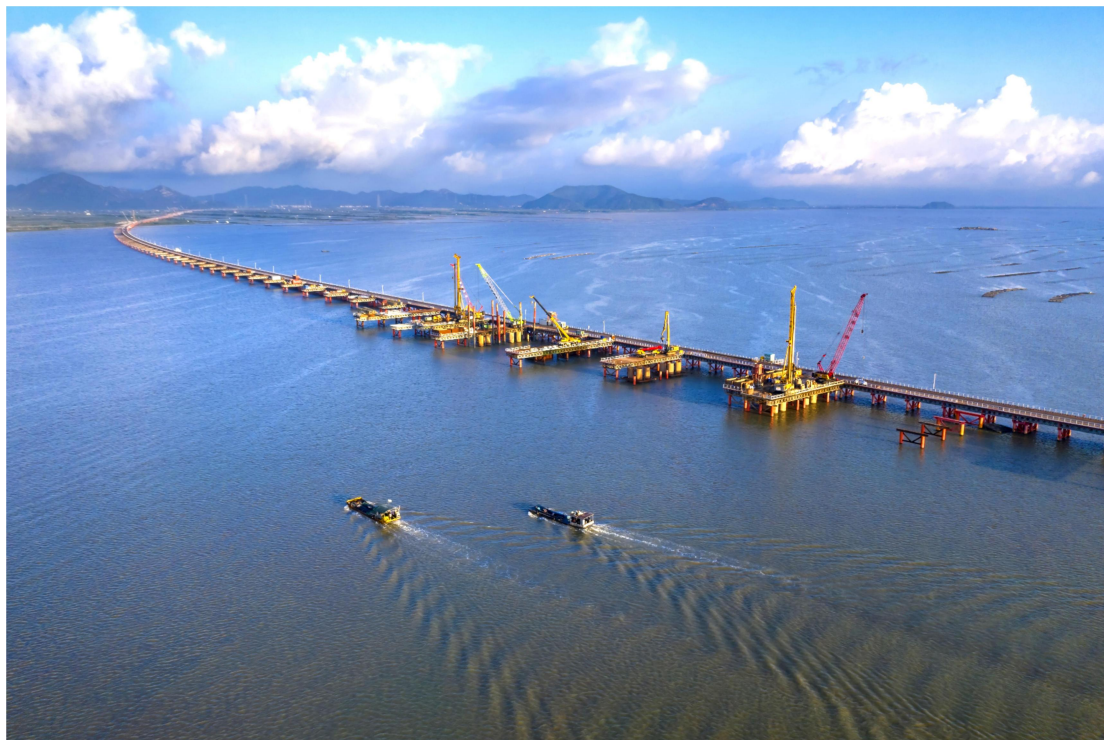
图 3-8 黄茅海跨海通道建设现场
