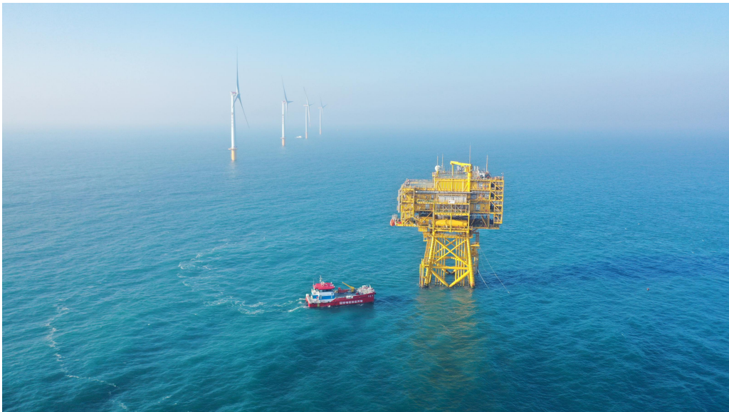
图 3-12 国电投 90 万千瓦海上风电项目 (揭阳市自然资源局供图)
