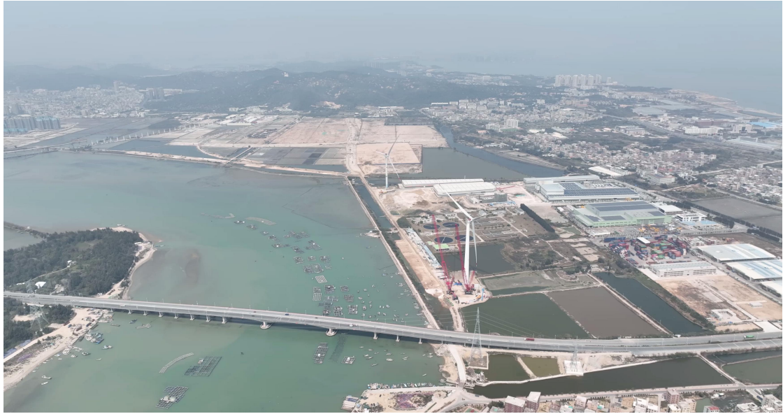
图 3-9 广东省风电临海试验基地 (汕头市供电局供图)
